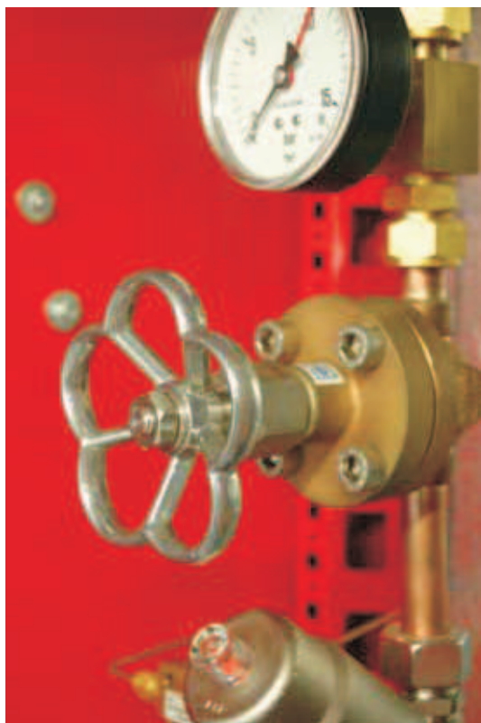
На фото: специальный вентиль, регулирующий скорость подачи.
