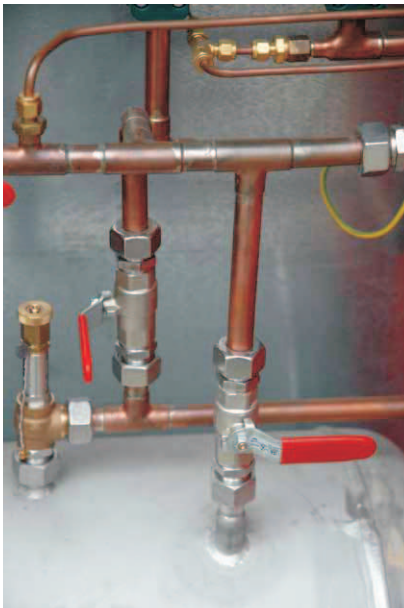
Фото: газовые магистрали, изготовленные из меди
