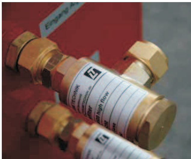
На фото: фильтры на входном отверстии для подаваемых газов Тип GR-8500, для газовых смесителей L+T, производительностью 15-100 Нм 3 /час
