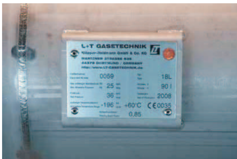
На фото: буферный сосуд из нержавеющей стали.
